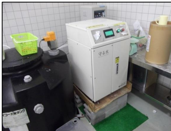
病院 長野県飯田市 ESS-ZERO ・厨房内で活用。 ・500ℓの貯水タンクを別途設置し、管理の徹底を行っている。
