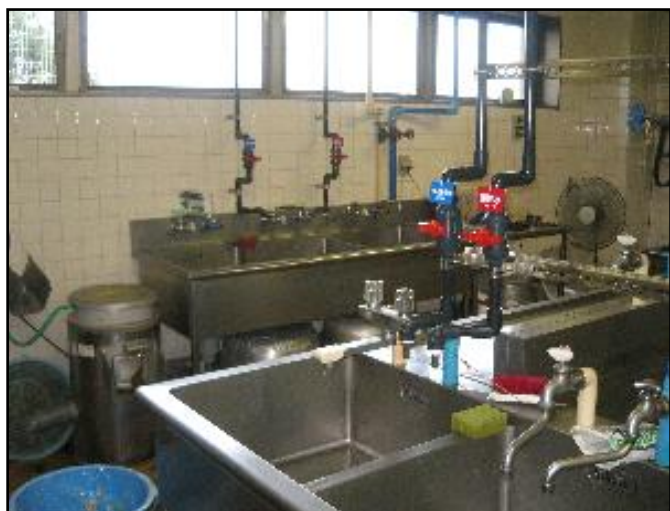
取水口(前処理室)
