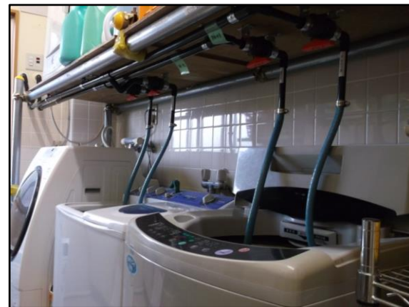
ケアステーション 滋賀県長浜市 ESS-100
