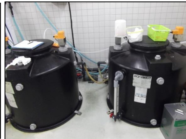
病院 長野県飯田市 ESS-ZERO ・厨房内で活用。 ・500ℓの貯水タンクを別途設置し、管理の徹底を行っている。
