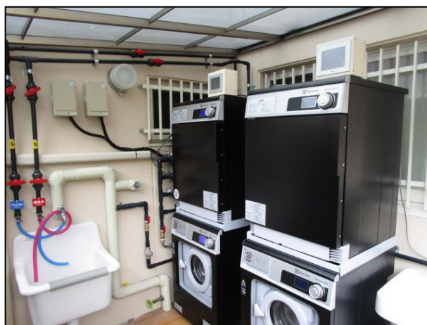
有料老人ホーム 愛知県日進市 ESS-300 ・既存施設に導入。洗濯機に接続。清掃用、浴室に取水口を設けています。
